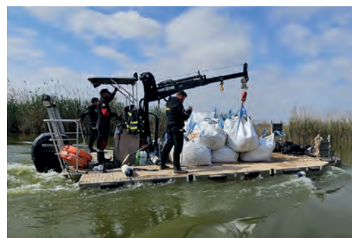
Trabajos para la recuperación de un «tancat» en el parque natural de la Albufera, el pasado 6 de abril.
